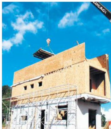
Madeira certificada utilizada em conjunto com outros materiais na construção civil garantem paredes mais sustentáveis. Além disso, a tecnologia de wood frame permite a construção de uma casa em três meses.
