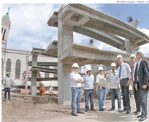
Convênio foi firmado no canteiro de obras do viaduto da Bento Gonçalves
