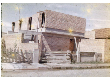
Figura 103. Residência Rafael Seligman em construção, vista desde a rua. Fonte: Microfilmes do acervo David Léo Bondar.
