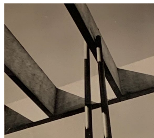
Figura 30. Detalhe do encontro do pilar metálico e da viga de concreto do MAM. Foto de David Léo Bondar em 1958. Fonte: Acervo David Léo Bondar.
