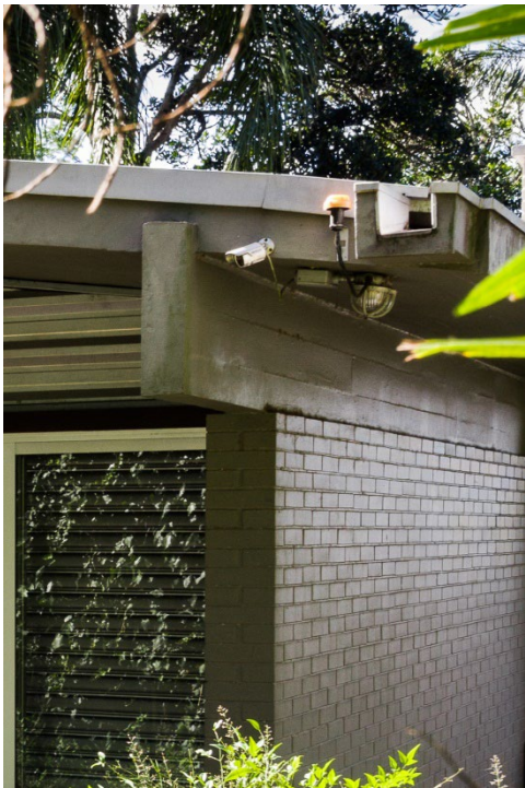
Figura 94. Detalhe da gárgula da laje em concreto, apoiada na viga de concreto que, por sua vez, se apoia na parede de tijolos que originalmente não era pintada nessa coloração.
