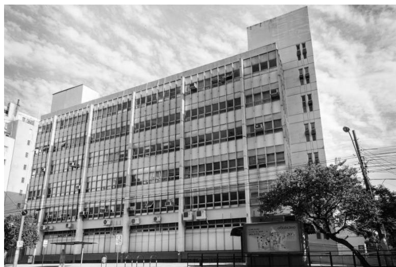
Figura 56. Hospital Presidente Vargas, fachada da Avenida Independência. Fonte: Eduarda G. Furini, 2019.
