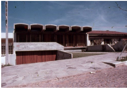
Figura 181. Foto da casa recém-construída. Fonte: Acervo David Léo Bondar.
