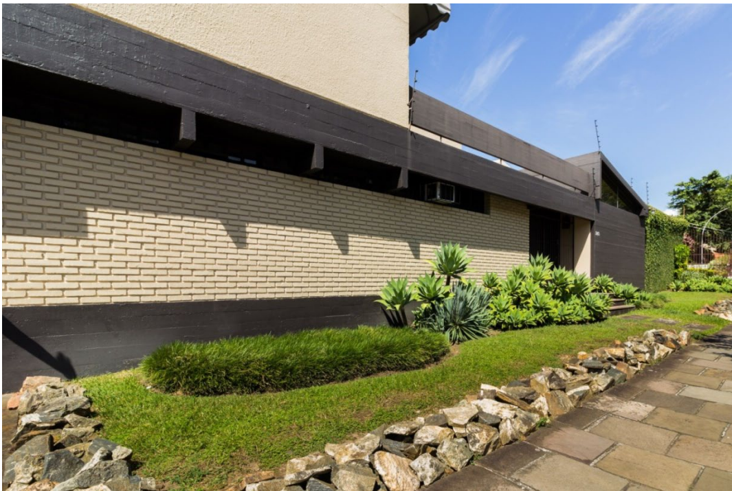
Figura 160. Fachada principal com estrutura de vigas de concreto protagonistas e bem marcadas. Foto: Eduarda G. Furini.
