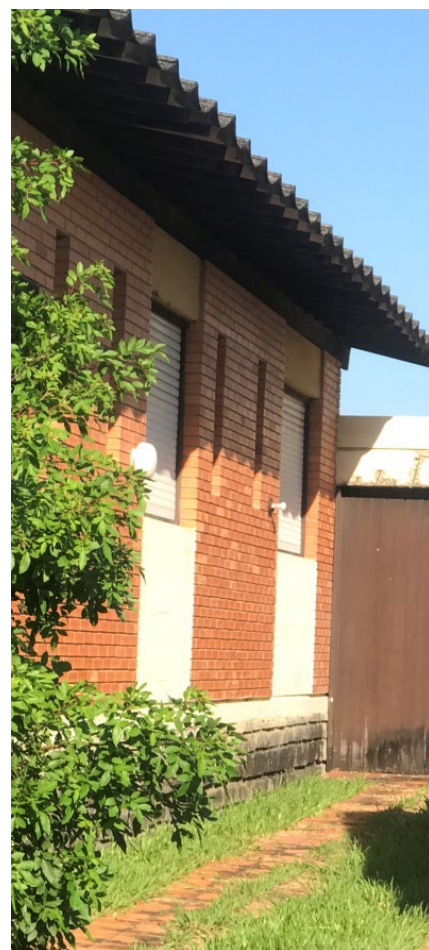
Figura 136. Detalhe da fachada lateral da zona dos dormitórios. Planos de tijolos interrompidos pelos vãos das aberturas.
