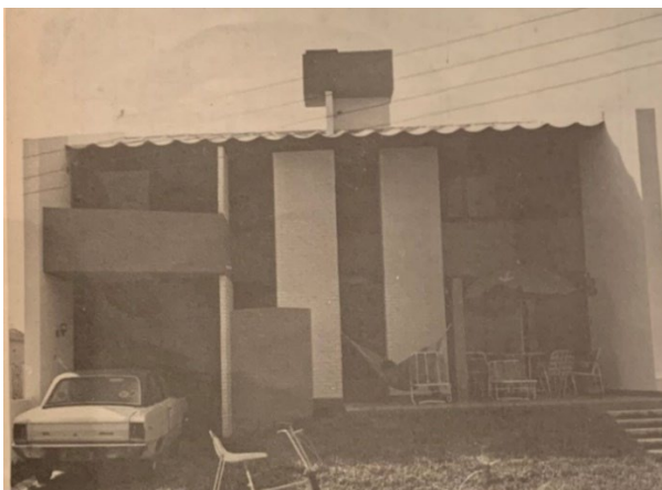
Figura 204. Fachada principal da Residência Abrahão Galbinsky. Fonte: Revista Espaço Arquitetura, 1977.
