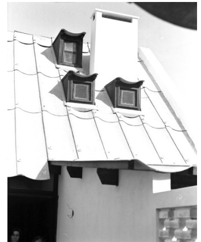
Figura 201. Vista de fundos da residência. Fonte: Acervo David Léo Bondar.
