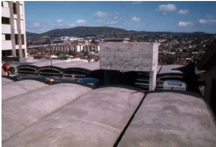
Figura 182. Foto da cobertura da Residência mostrando as zenitais, a caixa d'água e a cobertura em abóbada de concreto. Fonte: Acervo David Léo Bondar.
