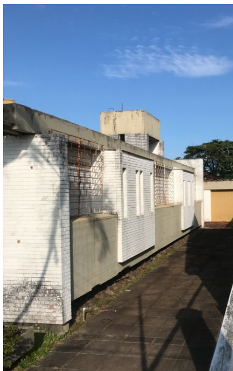
Figura 130. Fachada lateral da zona de dormitórios. Fonte: Fotografia do autor, 2019.
