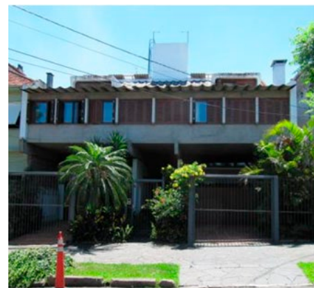
Figura 215. Fachada principal da casa antes de sofrer alterações na materialidade. Foto do autor, 2011.
