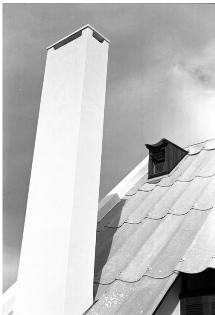
Figura 198. Detalhe da chaminé da lareira na cobertura de fundos. Fonte: Acervo David Léo Bondar.
