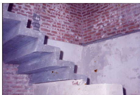
Figura 105. Detalhe da escada de concreto em construção. Fonte: acervo David Léo Bondar.
