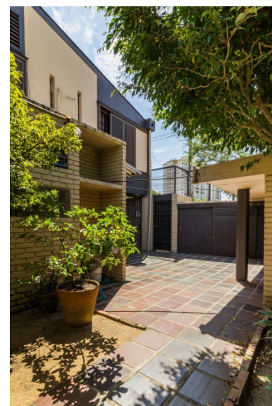
Figura 153. Fundos da residência. Foto: Eduarda G. Furini, 2019.
