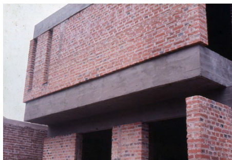
Figura 102. Residência Rafael Seligman em construção. Detalhe da fachada dos fundos. Fonte: Microfilmes do acervo David Léo Bondar.
