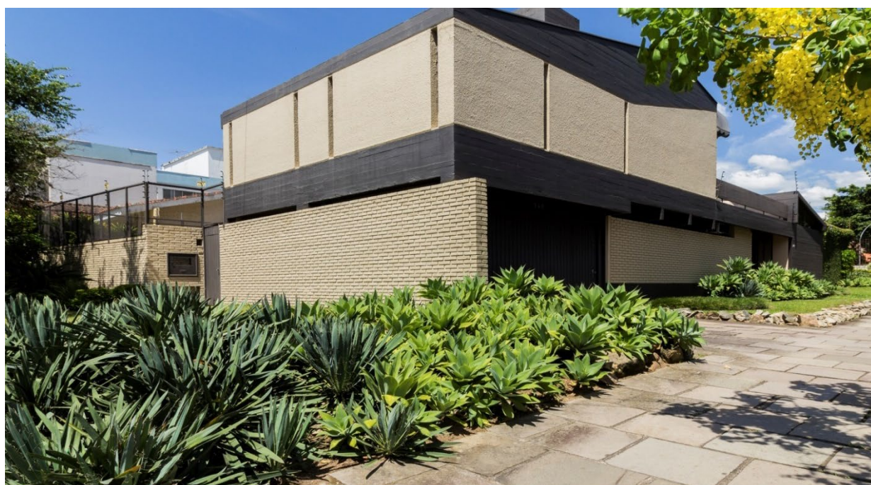
Figura 152. Fachada principal vista da esquina. Foto: Eduarda G. Furini, 2019.
