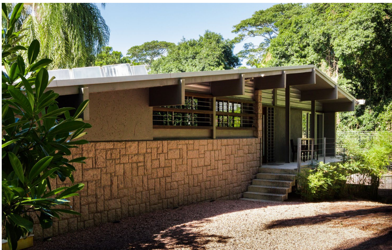
Figura 93. Foto atual do acesso principal à residência, já com alteração nas esquadrias e fechamentos que eram todos em madeira. Hoje, já têm um plano de estrutura metálica. Foto: Eduarda G. Furini, 2019.
