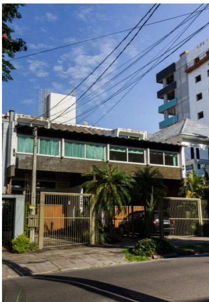
Figura 221. Fachada principal nos dias atuais. Foto: Eduarda Furini, 2019.
