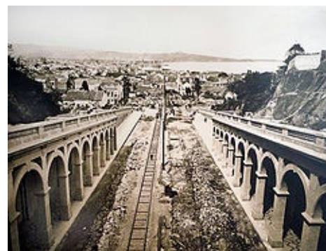
Figura 10. Foto da década de 1920 na construção do Viaduto Otávio Rocha na Avenida Borges de Medeiros.
