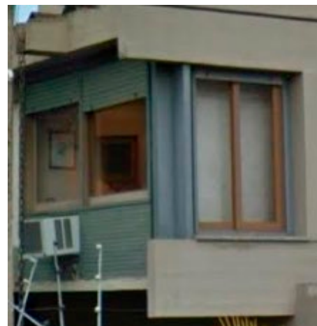
Figura 192. Detalhe da estrutura de concreto, do encontro dos dois planos da fachada e da gárgula com corrente para escoamento da água da cobertura. Fonte: Google Street View.
