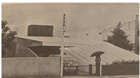
Figura 48. Residência do Arquiteto Cesar Dorfman, 1972. Fonte: XAVIER, MIZOGUCHI, 1987, p. 260.
