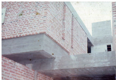
Figura 104. Residência Rafael Seligman em construção. Detalhe do encontro das vigas do volume superior e pérgula. Fonte: Microfilmes do acervo David Léo Bondar.
