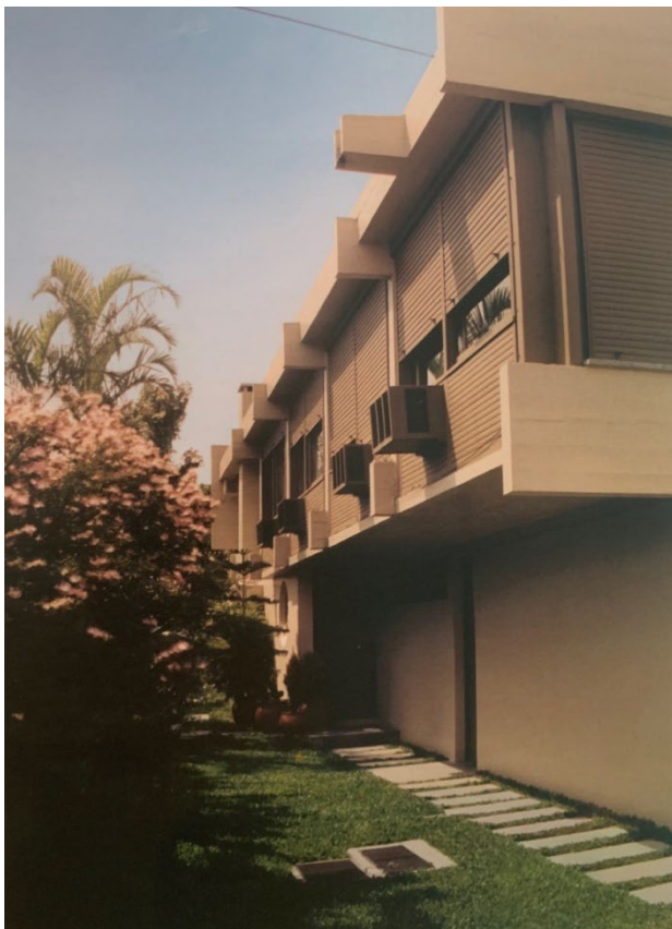
Figura 190. Fachada lateral da Residência Claudio Medvedovsky. Fonte: MOURA, SCHLEE, 1998, p. 205.
