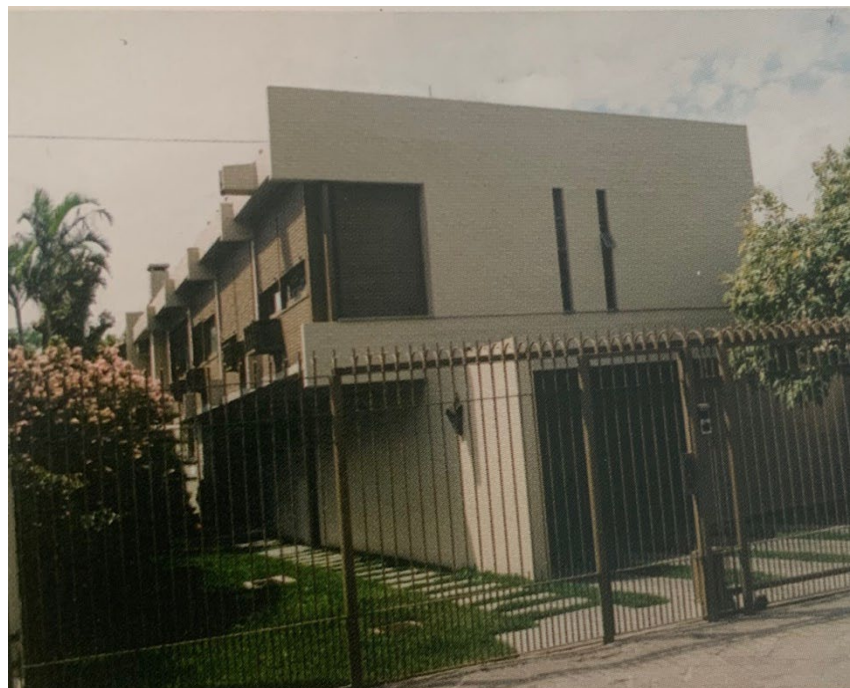
Figura 191. Fachada principal e lateral da Residência Claudio Medvedovsky. Fonte: MOURA, SCHLEE, p. 204.
