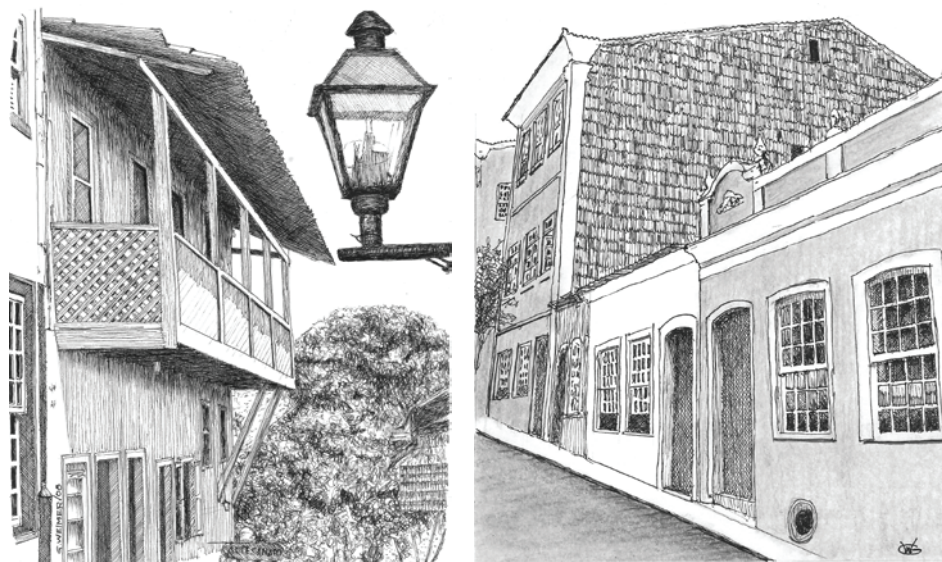
Figura 449: Uma varanda guarnecida por um parapeito fechado por adufas, em Diamantina, Minas Gerais.
