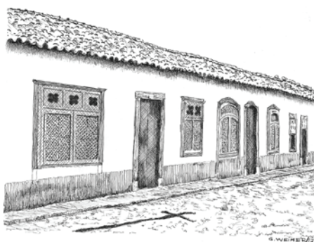
Figura 368: Casario em Tiradentes, Minas Gerais, destacando o emprego de janelas fechadas com rótulas de reixas.
