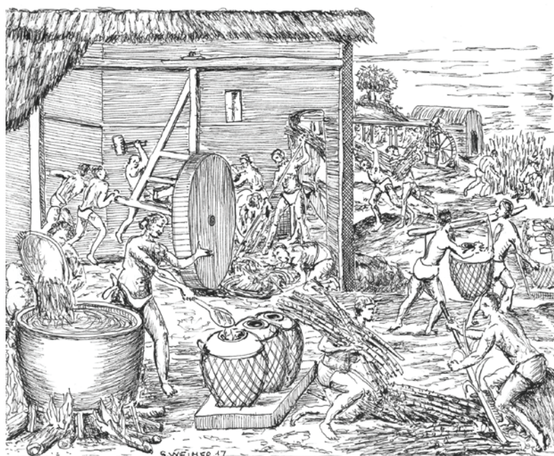
Figura 192: Engenho de açúcar com uma moenda de esmagamento da cana por uma mó, segundo de Bry 96 .
