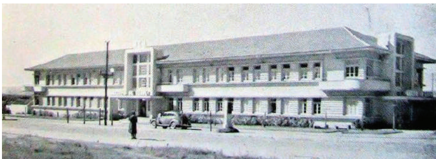
Figura 135: Centro de Saúde Modelo – Vista da esquina da Rua Sebastião Leão com Avenida João Pessoa, 1942. Fonte: fotosantigas.prati.com.br.
