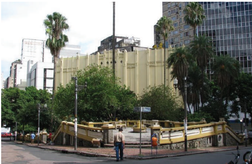
Figura 41: Praça Otávio Rocha, 2009. Vista do terraço sobre os banheiros. Fonte: (prati.com.br)
