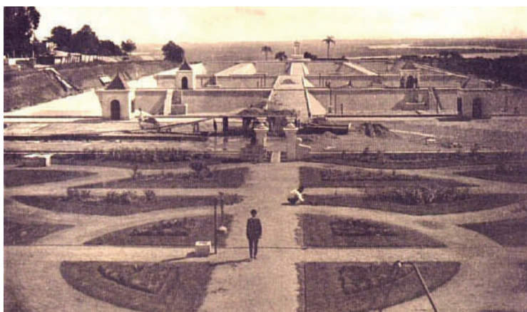
Figura 29: Hidráulica Guaibense. Construção de novos tanques, 1909. Foto: Calegari. Fonte: (fotosantigas.prati.com.br)
