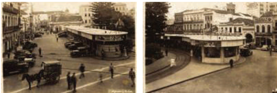
Figura 44 e Figura 45: Abrigo de Bondes da Praça XV. Fotos antes da ampliação. Projeto de Adolpho Siegert. Fonte: (Jornal do Mercado, 2011)
