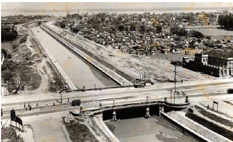
Figura 154: Ponte da Azenha. Fotografia durante a canalização do Riacho, 1940. Fonte: Fotos Prati
