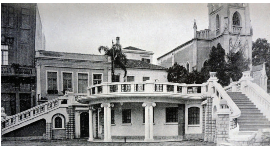
Figura 39: Praça Otávio Rocha. 1929. Vista dos banheiros sob o terraço na esquina da Rua Senhor dos Passos com a Otávio Rocha. Fonte: (A. BINS, Relatório apresentado ao Conselho Municipal, 1929)
