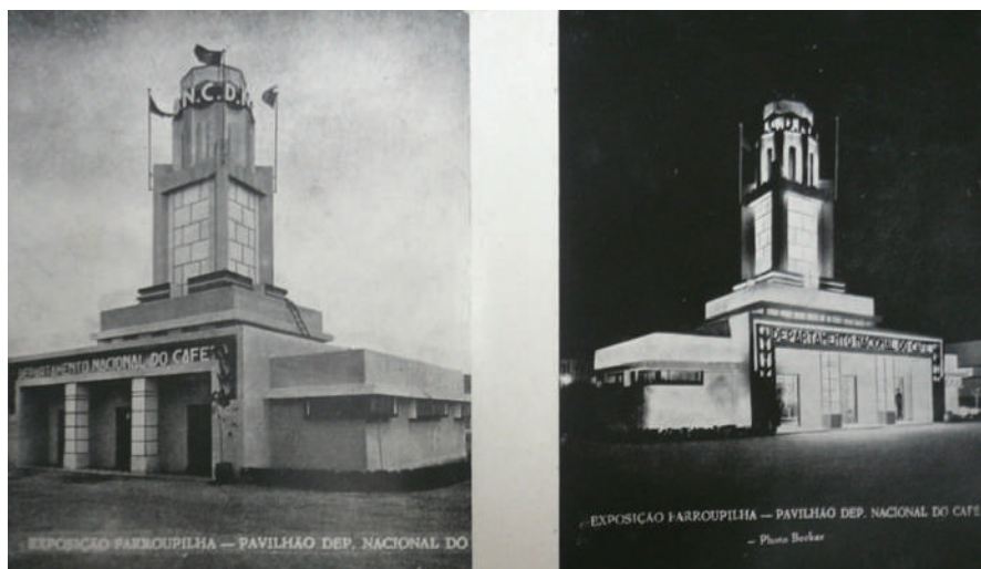
Figura 90 e Figura 91: Pavilhão do Departamento Nacional do Café, 1935. Vista diurna/noturna. Fonte: ArqCentro-PROPAR.
