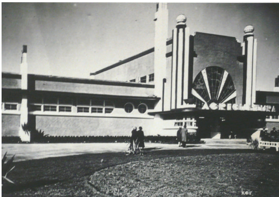
Figura 72: Pavilhão da Agricultura, 1935. Vista frontal. Fonte: ArqCentro-PROPAR.
